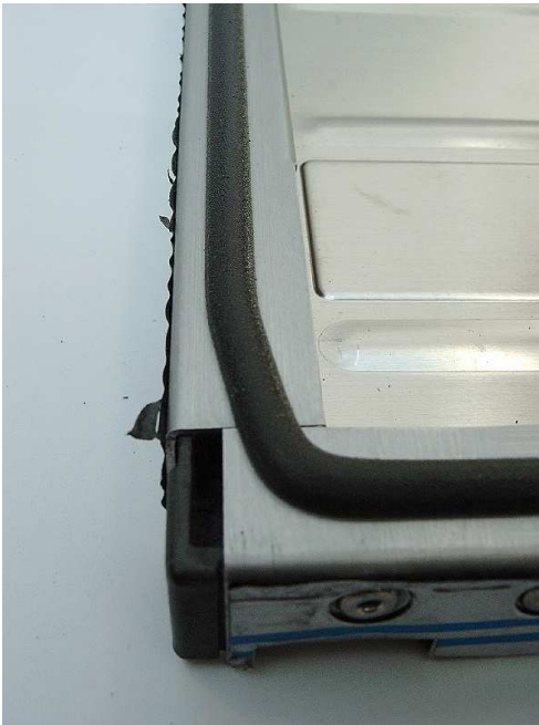
Abb. 8 Deckel Transportbehälter mit Silikon-Schaumdichtung
