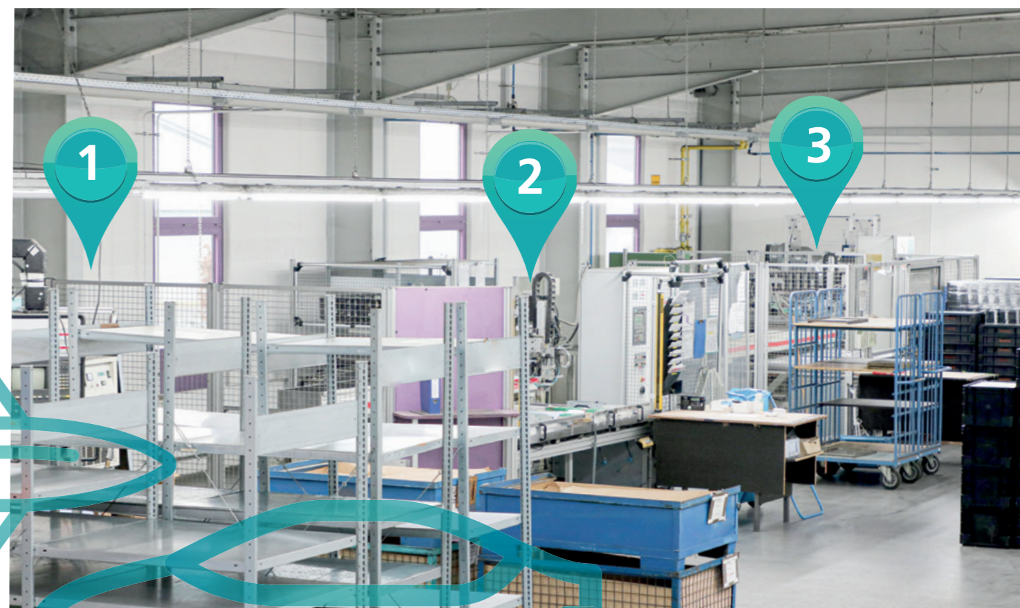
3 der bei Polyprocess eingesetzten CNC-gesteuerten Misch- und Dosiereinrichtungen
